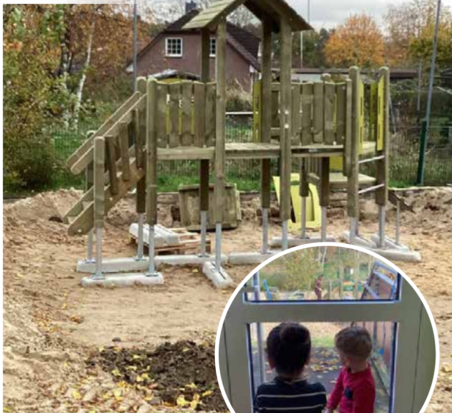
Baufortschritt am Tag 2 © Katrin Vorbringer
